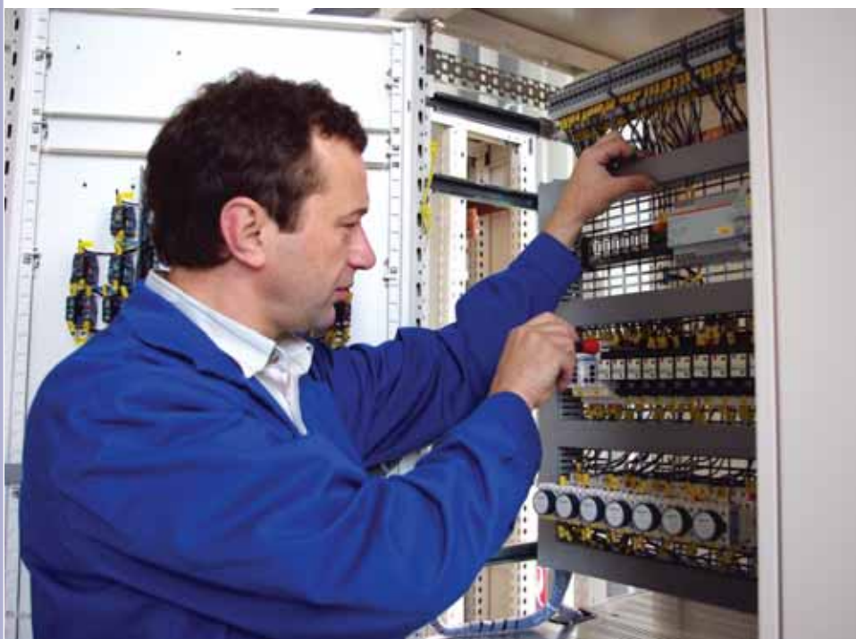
Электромонтаж силовых цепей шкафа низкого напряжения PRISMA PLUS.
